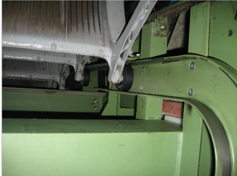
Resim 1.14: Üst kılavuz ray basamak ve yolcu yükünü taşır
