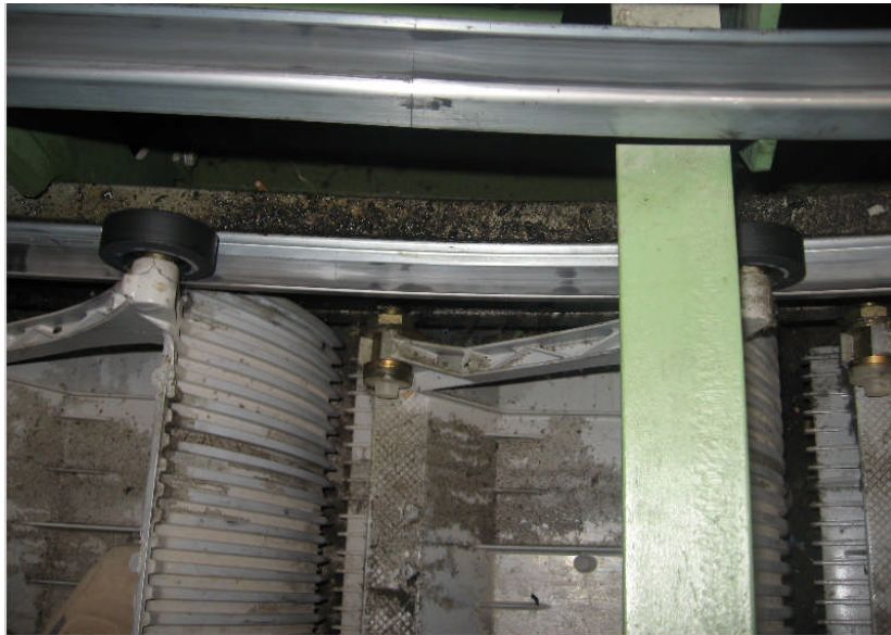
Resim 1.12: Basamakların yüksüz olarak geri dönerken kullandığı raylar
